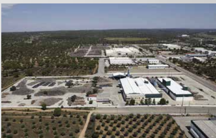
Sedacor III Ponte de Sôr
